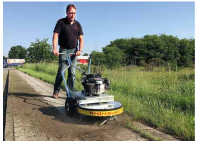
Extremer Grünbewuchs wird effizient entfernt.
